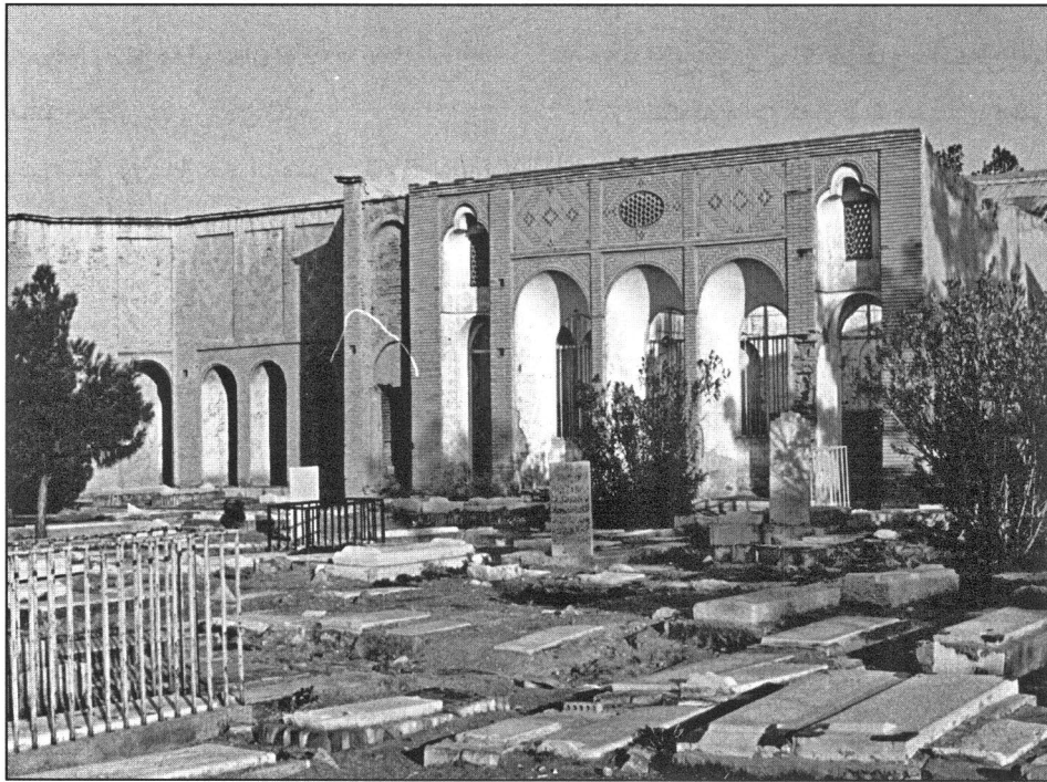
حجره‌های تکیه ریزی قبل از تخریب
