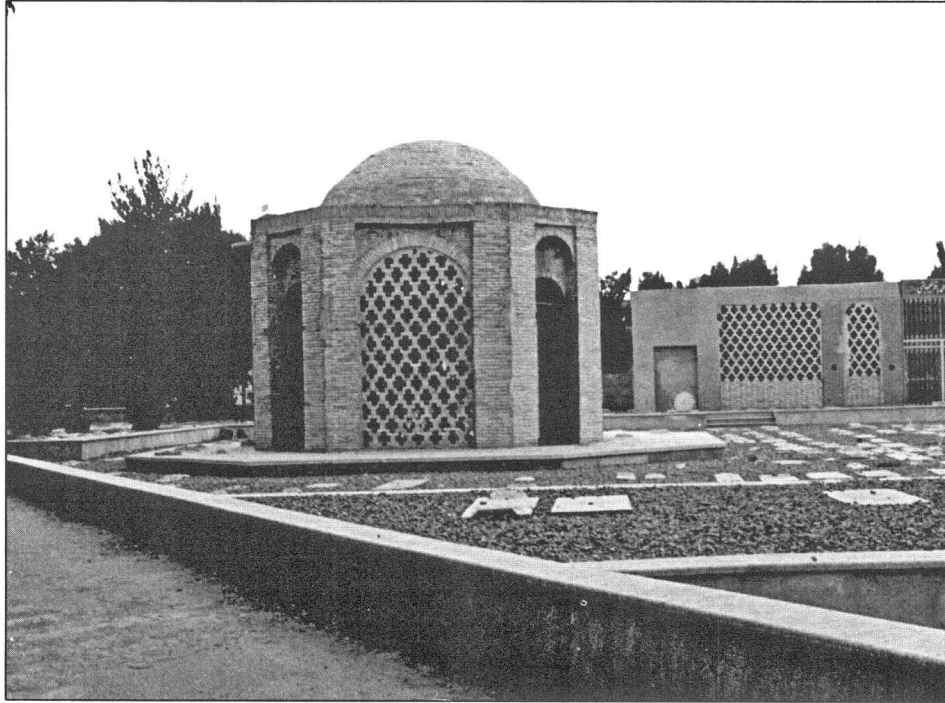
تکیه آقامجلس بعد از تخریب حجره‌ها و نوسازی
